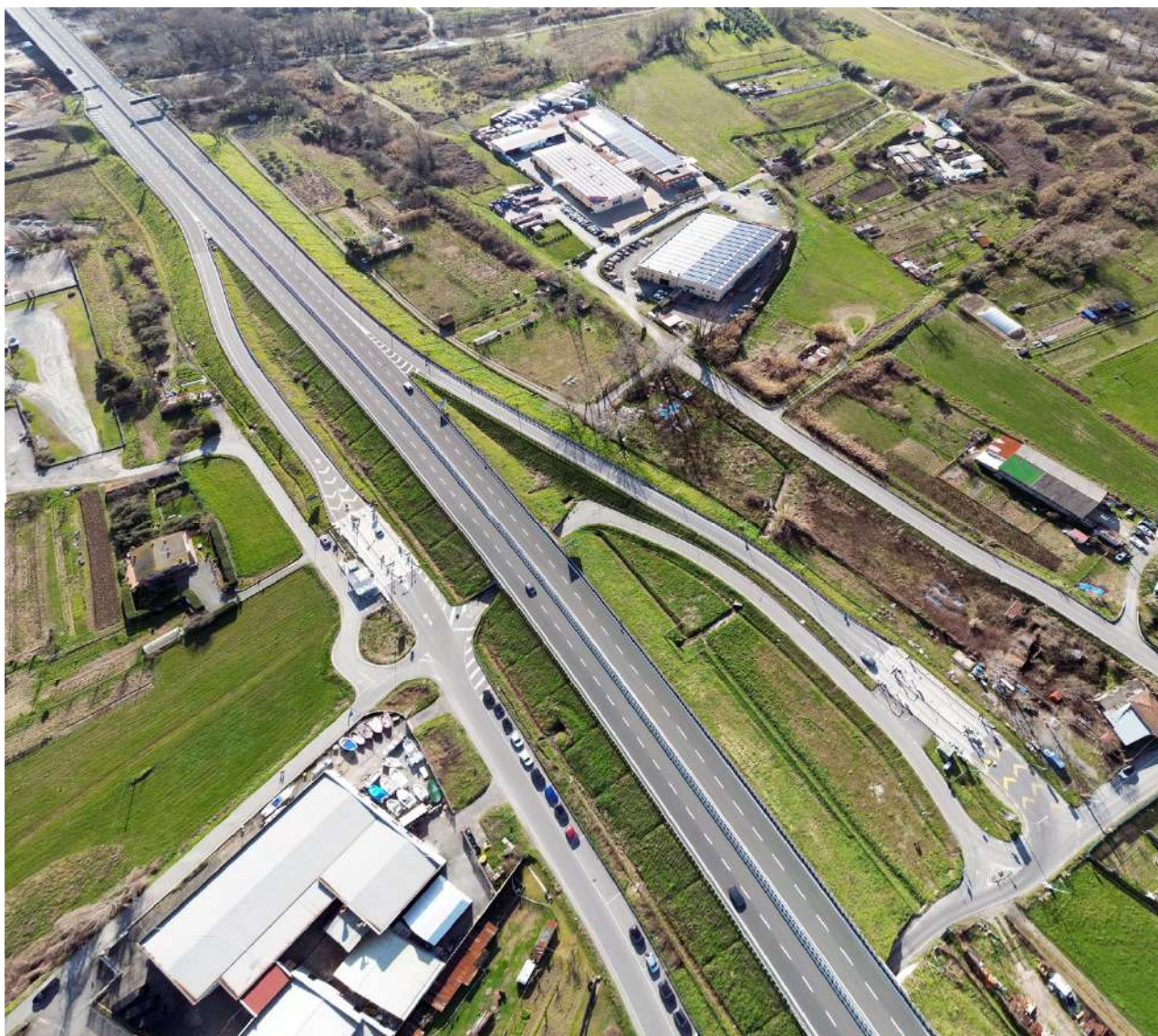
Figura 2 - Individuazione dell'area di realizzazione delle rampe dell'asse autostradale A12 da drone.
