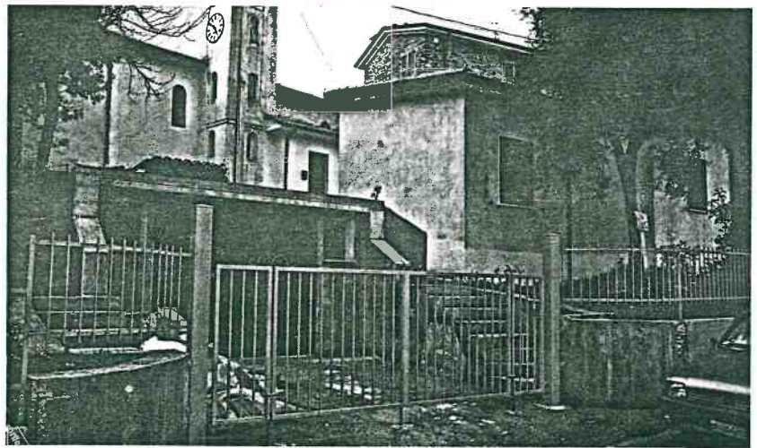
Vista prospettica del fianco
