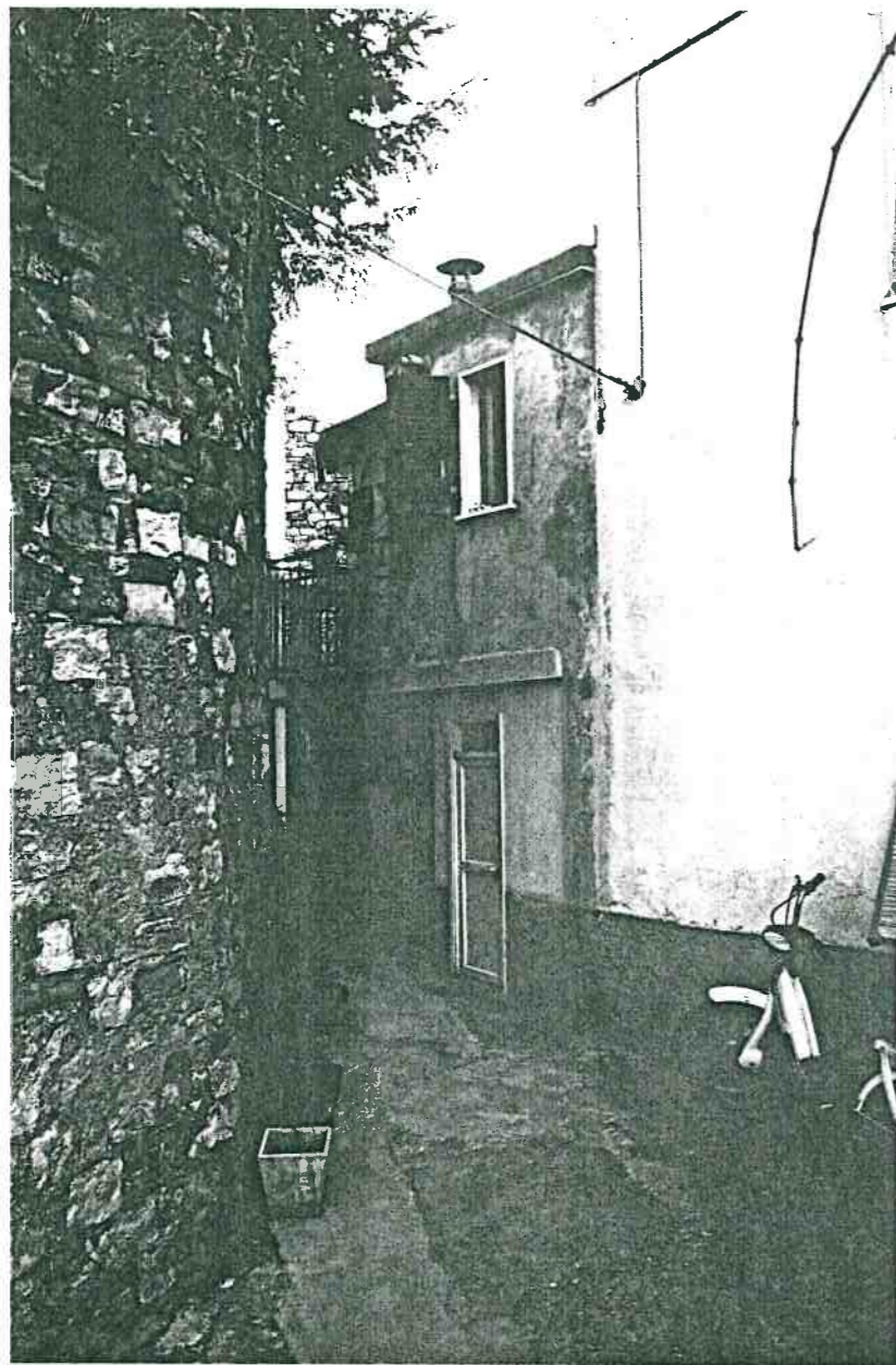
Visia prospettica del fronte da Via Foggio
