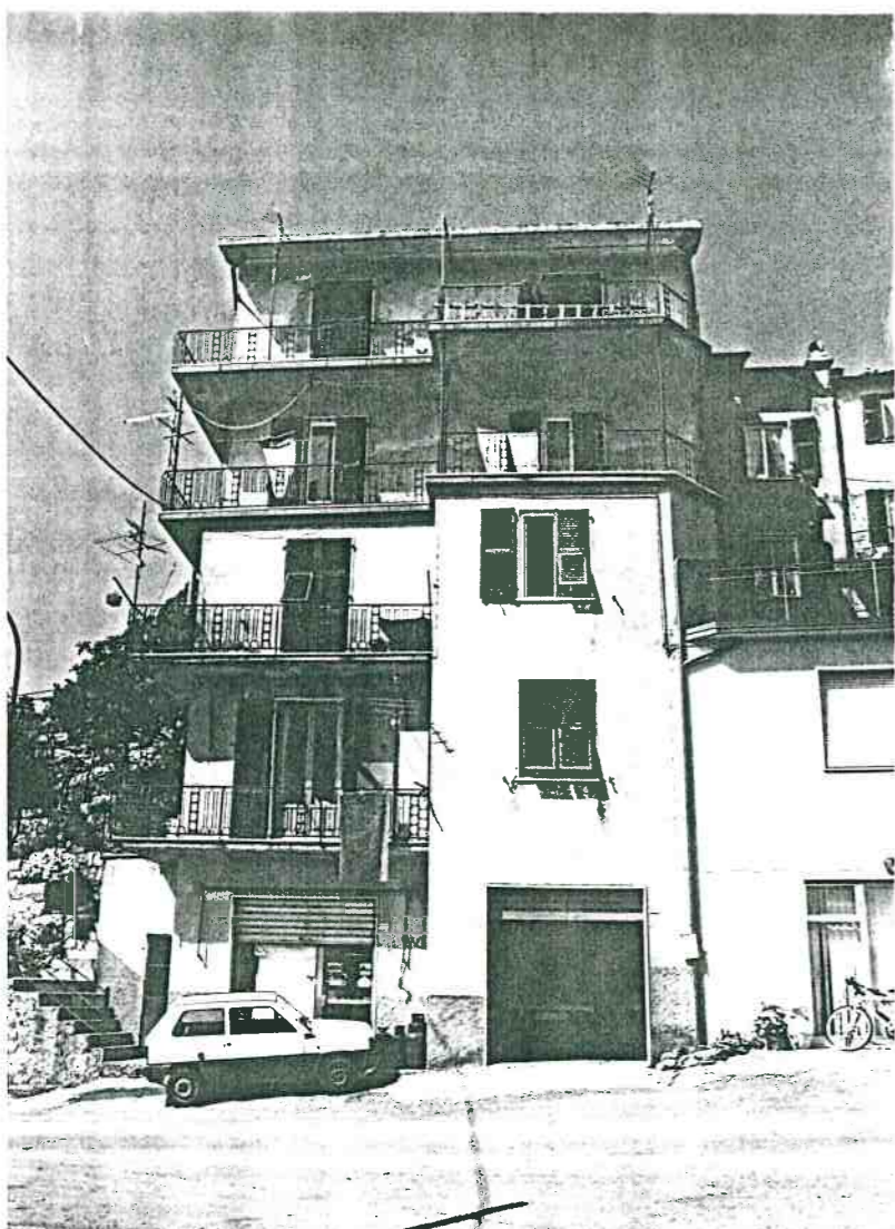
Vista prospettica del retro da Via Codalina
