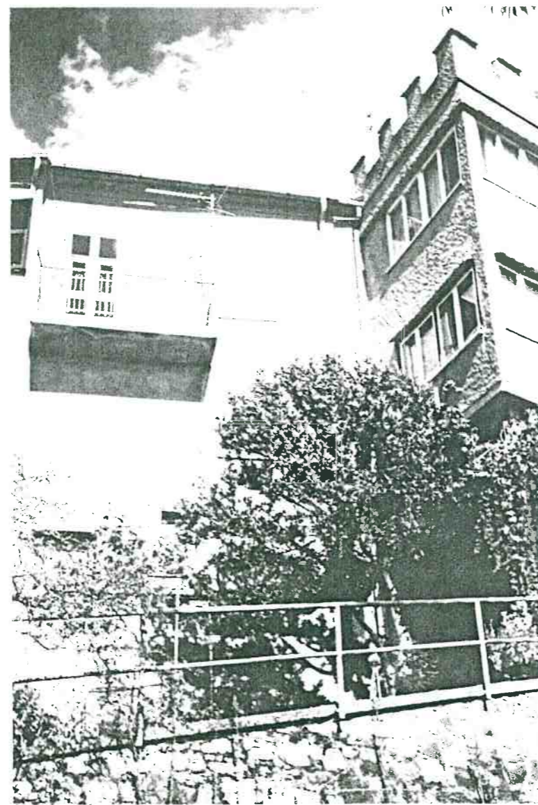
Vista prospettica del retro dalla strada Provinciale
