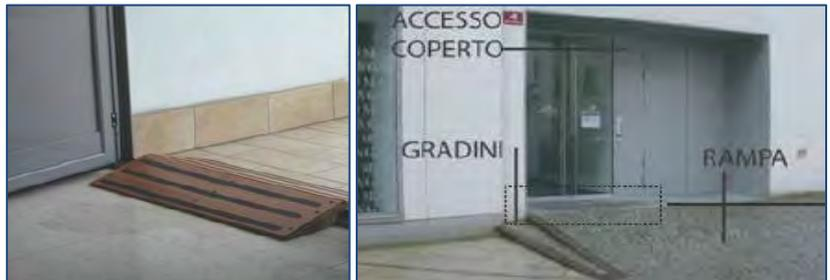
Figura 26e Figura 27 - Esempi di rampa di collegamento
